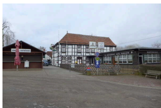
Restaurant-Pension „Gartenhaus“ Pansfelde
