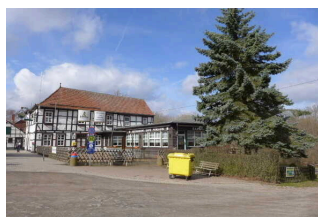
Restaurant-Pension „Gartenhaus“ Pansfelde
