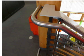
EG zum 1. OG: Handlauf an Treppe
