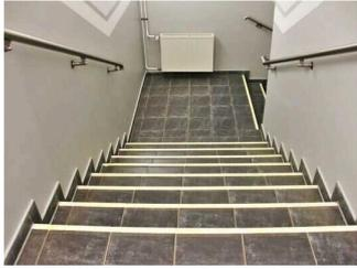
Blick vom EG auf die Treppe in Richtung UG. Nach dem Zwischenpodest dreht sich der Treppenverlauf um 90°. Die Stufenvorderkanten sind alle optisch kontrastreich ausgeführt.
