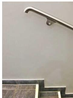
Detail zur Gestaltung der Handläufe am Ende der Treppenläufe.
