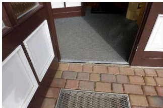
1. Tür Windfang Eingangsbereich
