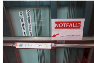
Bedienelemente im Aufzug
