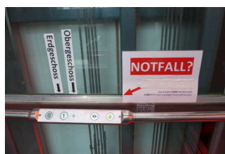
Bedienelemente im Aufzug
