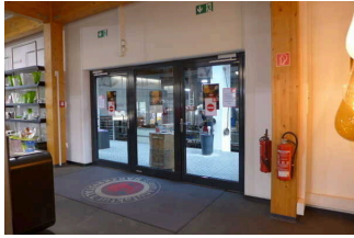
Tür zur Plattform
